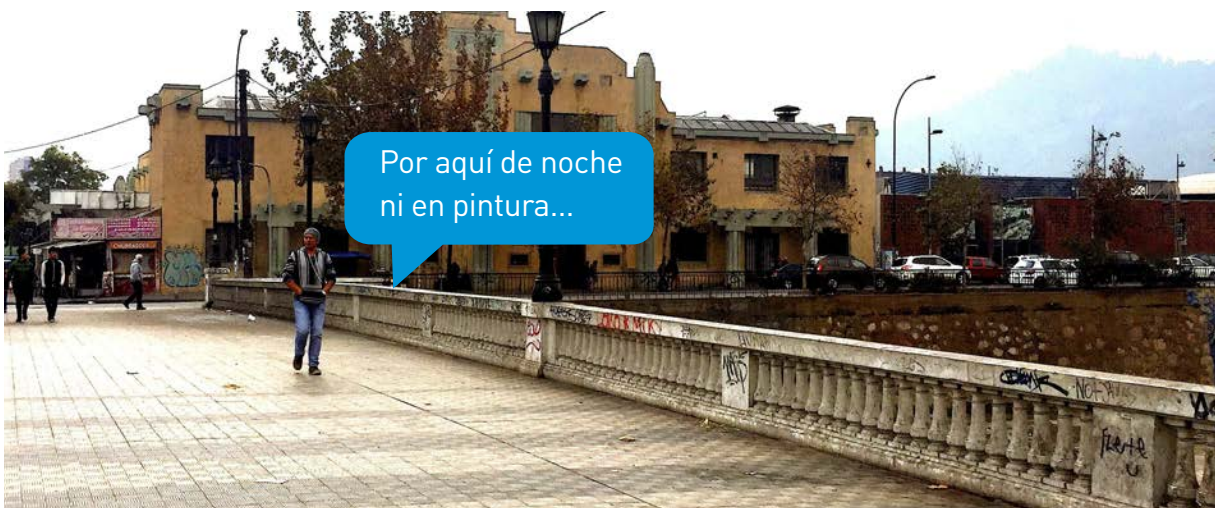
Poca illumination en el Puente Padre Hurtado
