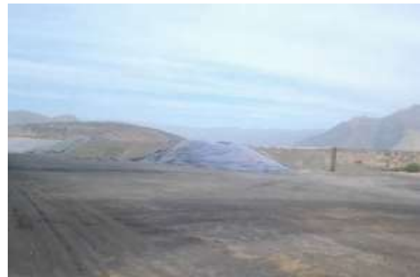
Figura 24. Fotografías Tranque de Relave N°5, de Cementos Polpaico. Fuente: Elaboración propia.
